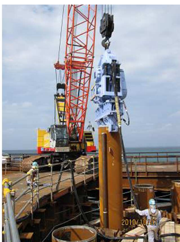
現場の施工状況
